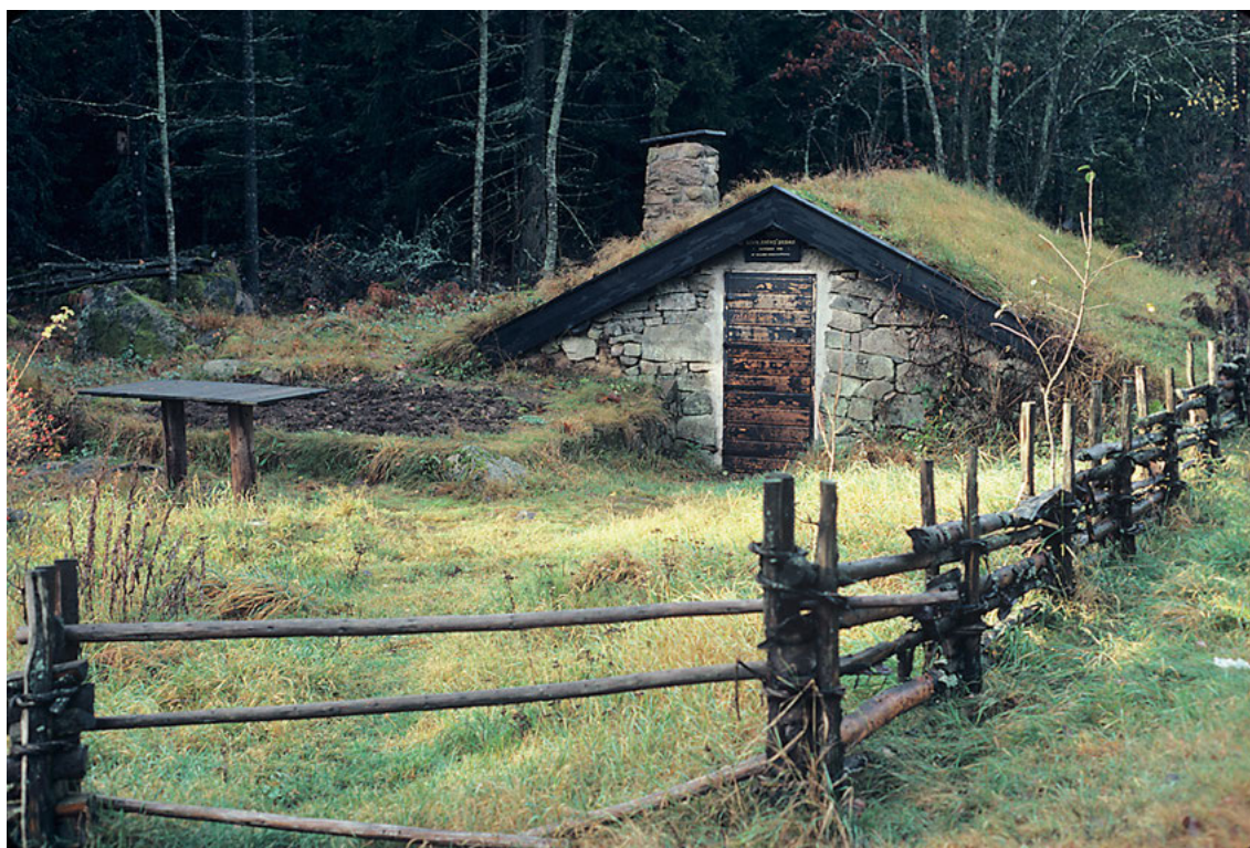
FIGUR 10. Backstuga från Gullabo socken i Småland är ett exempel på den fattigbebyggelse, som finns över stora delar av södra Sverige och som övergavs senast under 1940- och 1950-talen. Merparten av denna bebyggelse är idag försvunnen eller kan vara svår att skilja från vanliga jordkällare. Som dokument över den svenska fattigdomens betydelse kan de inte överskattas. Foto Gert Magnusson 1977.
